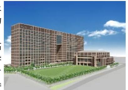
照ください）。建物規模は約53,200㎡、高さ約54mの13階建てです。大きく分けて、校舎棟と体育・厚生棟に分かれており、校舎棟は鉄骨造、体育・厚生棟は鉄筋コンクリート造となります。
