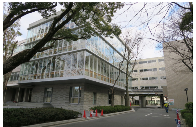
1号館増築棟 外観
